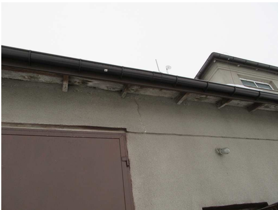
Zarysowania powstałe w wyniku niedostatecznego przekroju elementów nadprożowych. Zostanie naprawione w trakcie przebudowy.
